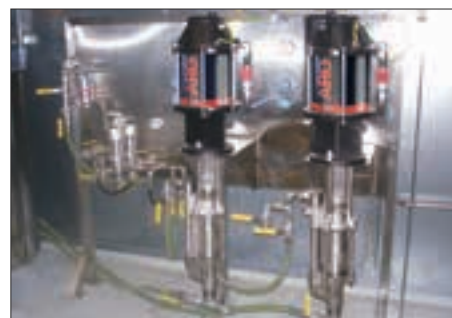
4-kuulilised 4 : 1 suhtega kolbpumbad värvivalmistusprotsessis
