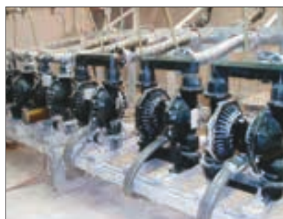
Keraamikatööstuses savi teisaldamiseks kasutatavad 3" membraanpumbad kelgule paigaldatuna
