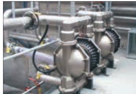
Lahtise materjali edastamiseks paigaldatud 3" roostevabast terasest membraanpumbad
