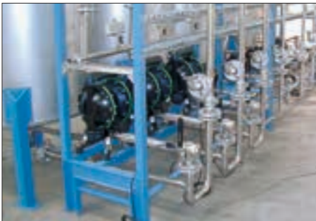
Keemilise reaktori toiteks paigaldatud 1 ½" alumiiniumist membraanpumbad
