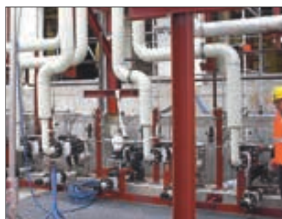
Vesinikfluoriidhappe allalaadimiseks kasutatavad PVDF-st pulsatsioonisummutitega roostevabast terasest 2" membraanpumbad
